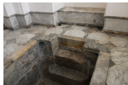
Marmorbadet, kar med haner og vandtilførsel gennem skjulte rør.
